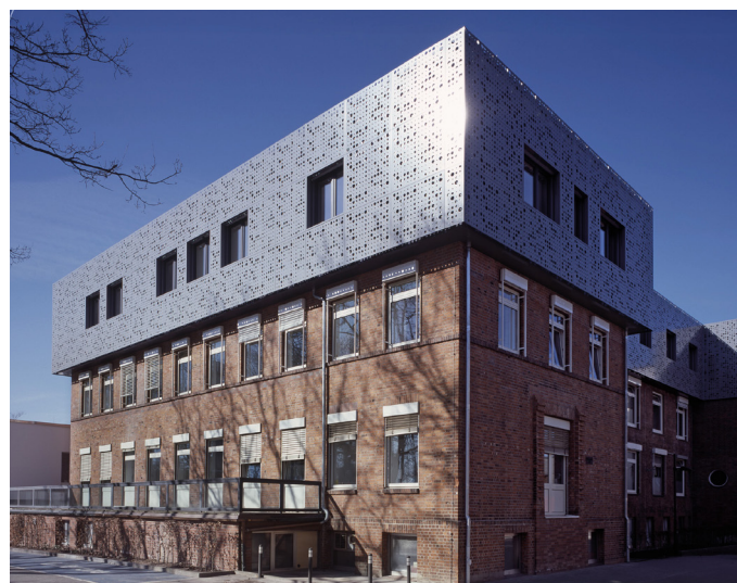
Abb. 39: Aufstockung des Kinderkrankenhauses
