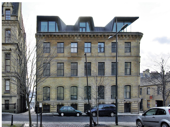
Abb. 49: Ansicht der Aufstockung
