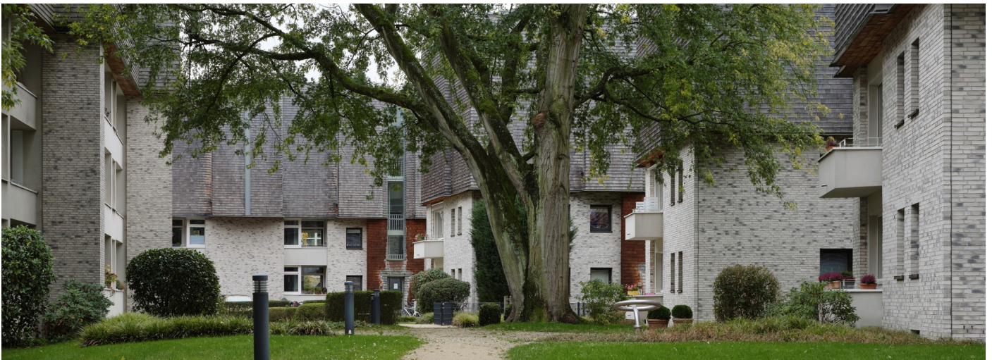
Abb. 55: Aufstockungen in Holztafelbauweise
