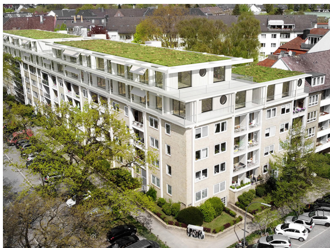
Abb. 52: Visualisierung der Aufstockung
