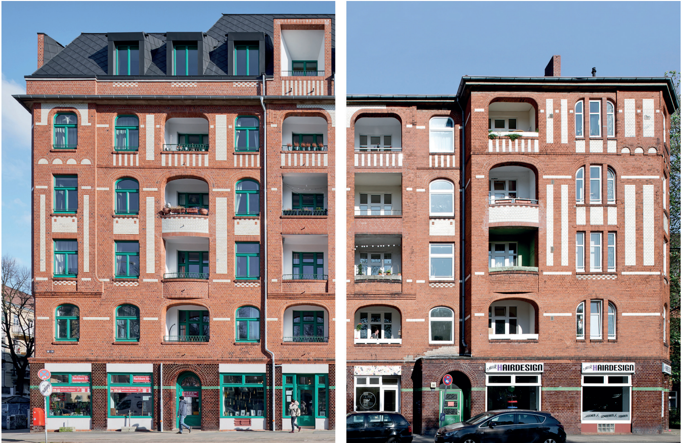
Abb. 6: Straßenansicht vor und nach der Aufstockung
